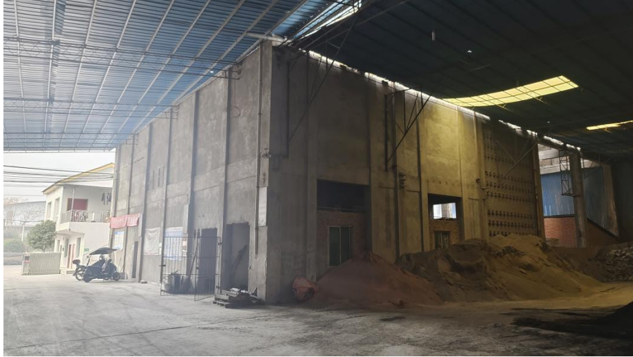
现有项目原料库及其出入口现场照片
