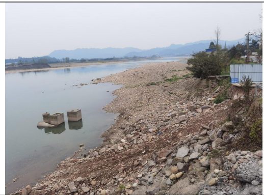
石棉渡改桥起点处
