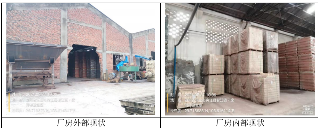
图 2-9 拟建地厂房现状照片
