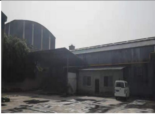
已建封闭式厂房
