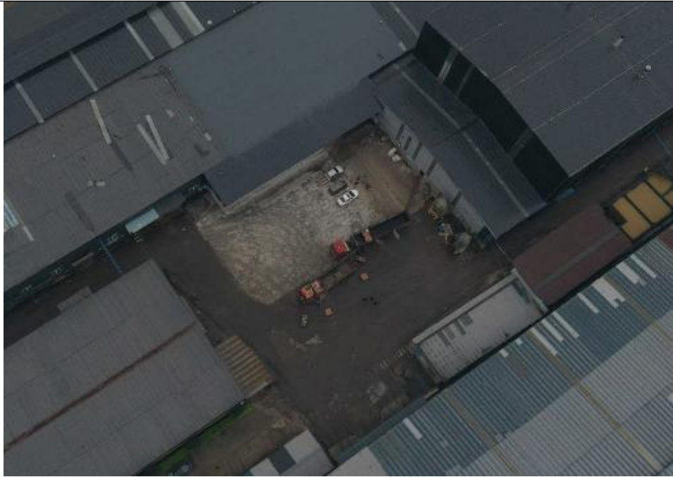
已拆除煤气站区域现状
