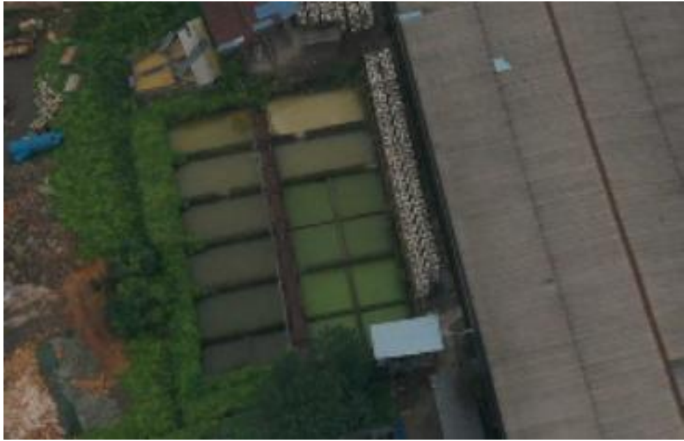
二级絮凝沉淀池
