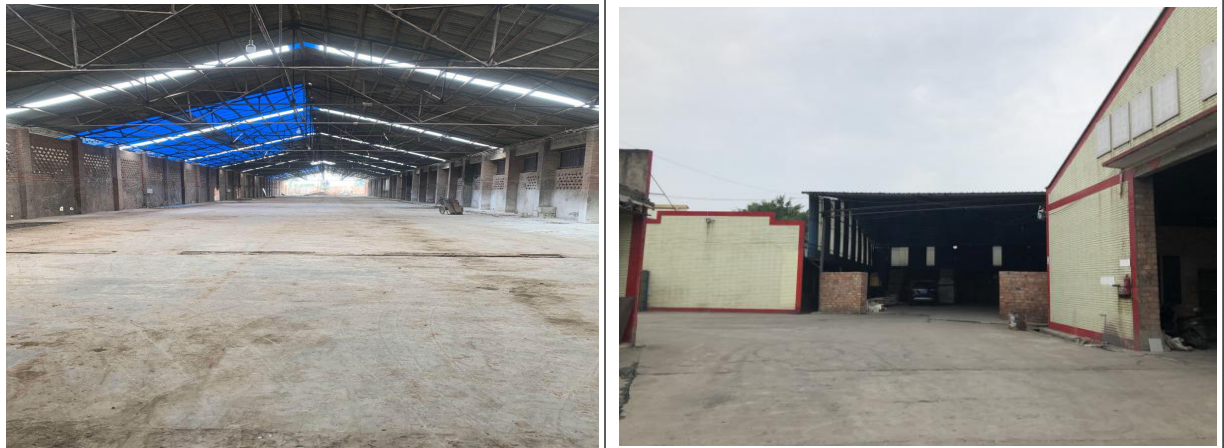
图1-2 租赁厂房现状照片
