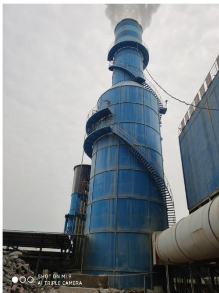
压机废气排气筒（须整改）
