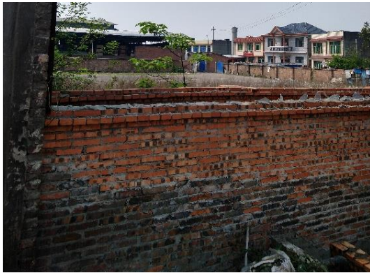
南厂界实心砖围墙
