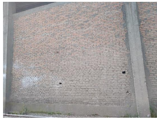
北厂界厂房砖混结构墙体
