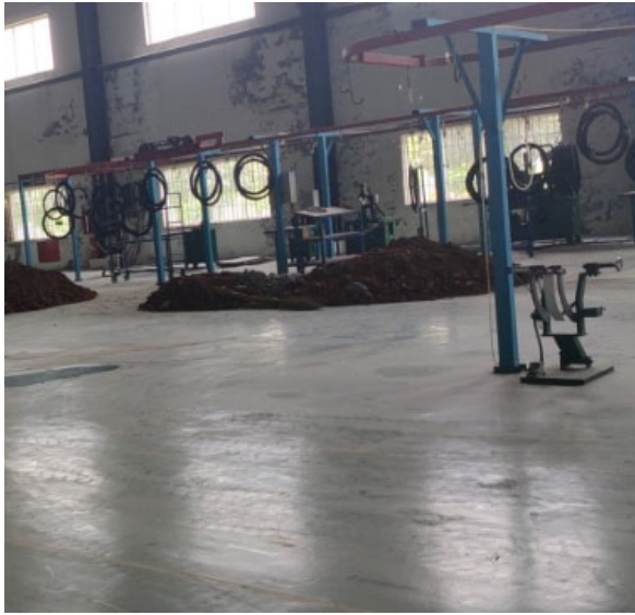
项目场地现场照片一
