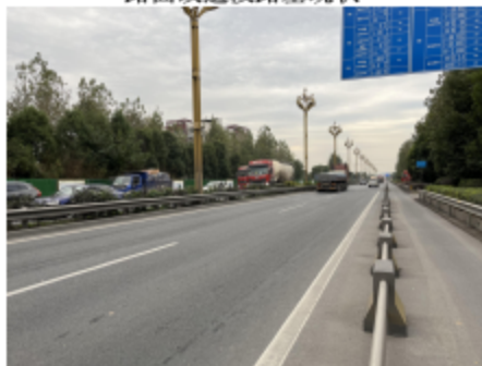
路面改造段路基现状
