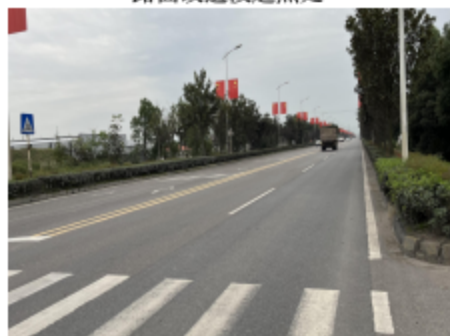
路面改造段路基现状
