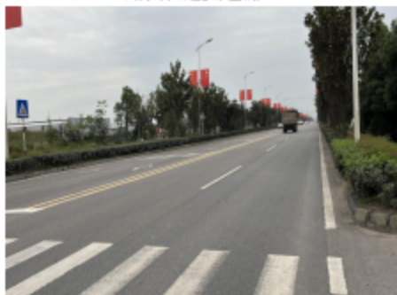
路面改造段路基现状
