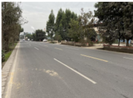
利用既有 S428 道路起点现状
