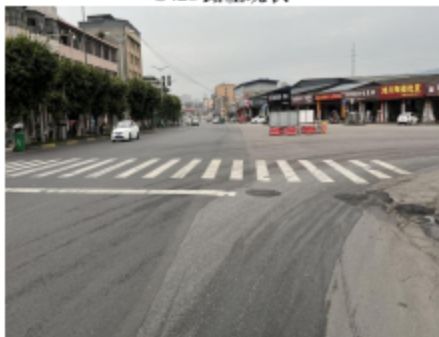
利用既有 S428 道路终点现状
