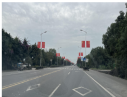
路面改造段路基现状
