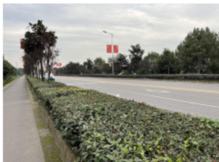
路面改造段起点处
