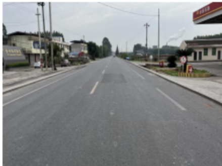
S428 路基现状
