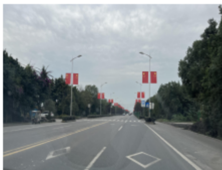
路面改造段路基现状
