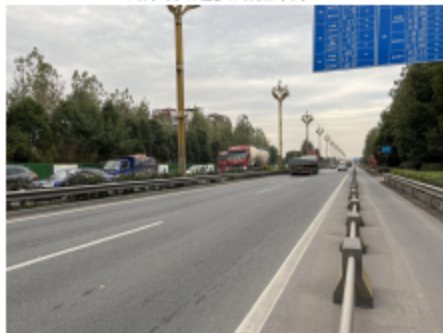
路面改造段路基现状
