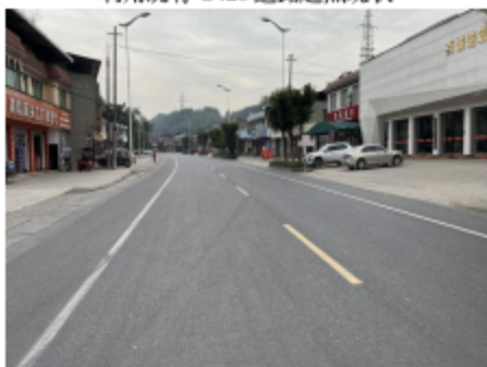
S428 路基现状
