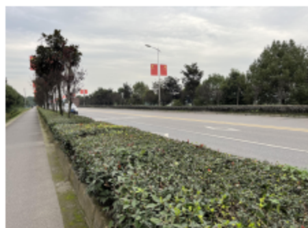
路面改造段起点处
