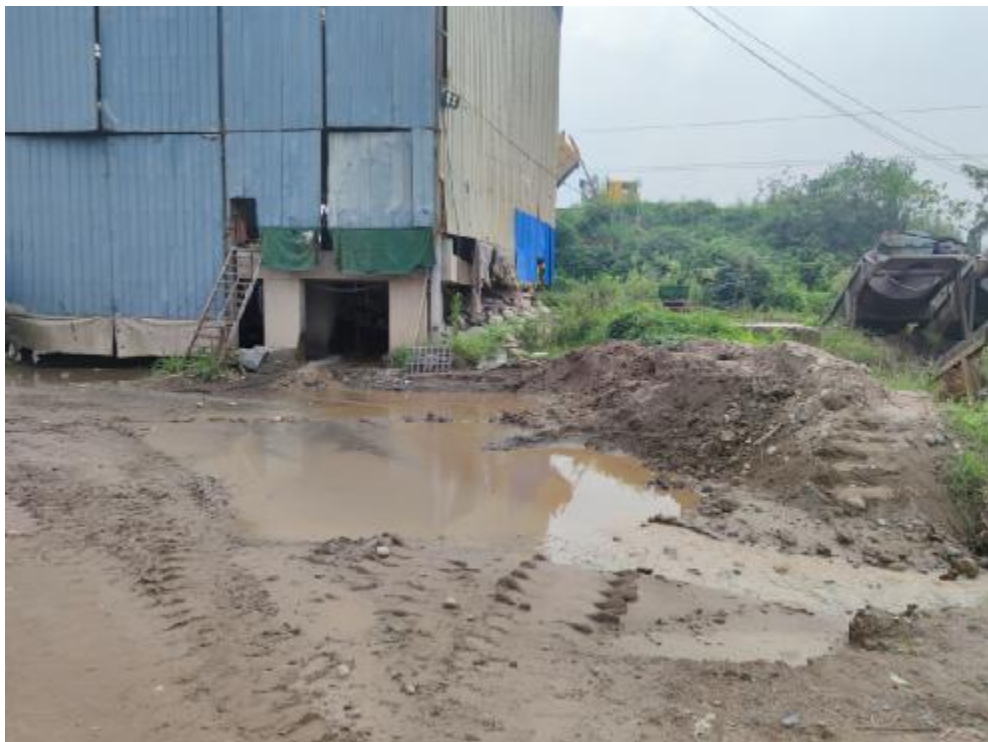
图 3.6-5 项目洗砂设备污水收集设施不完善，污水横流
