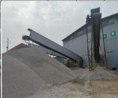
项目传送带廊道及堆场现状
