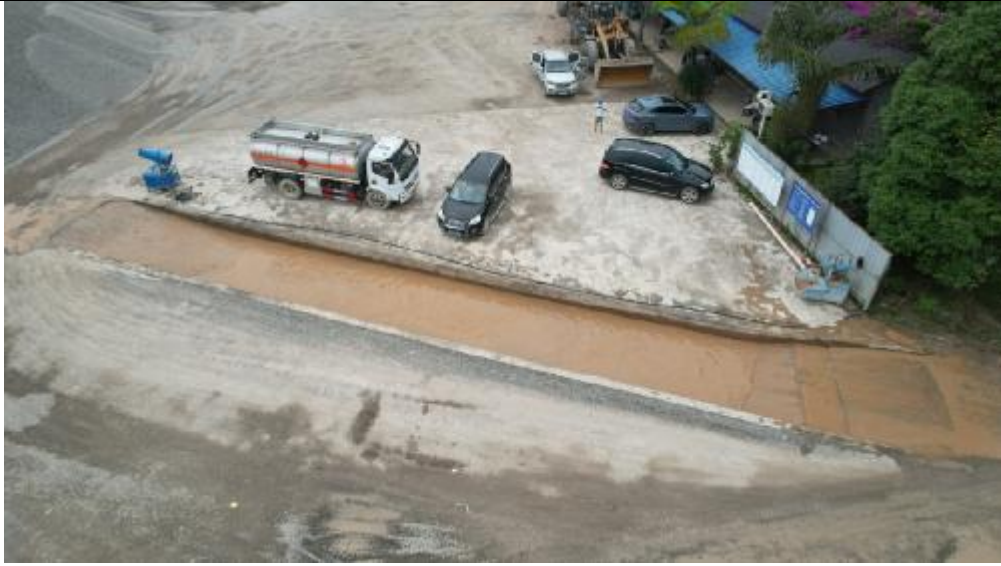
图 3.6-1 项目正门处的洗车槽
