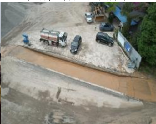
出厂车辆洗车槽
