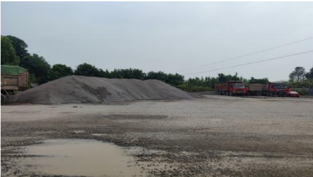
图 3.6-2 项目当前原料及成品堆场未采取围挡、覆盖、洒水措施
