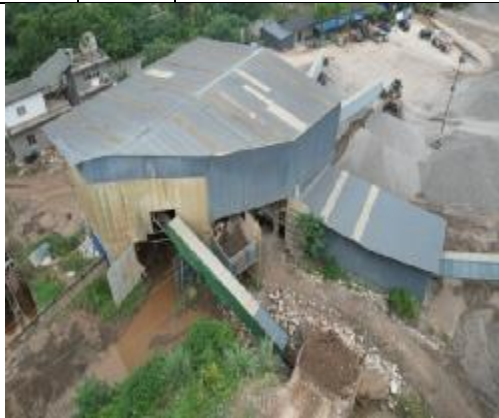
项目生产车间现状
