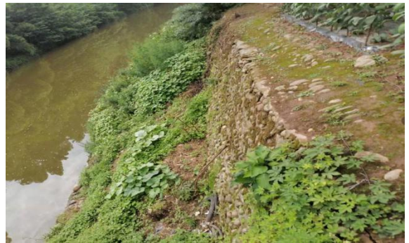
河道加固段现状照片
