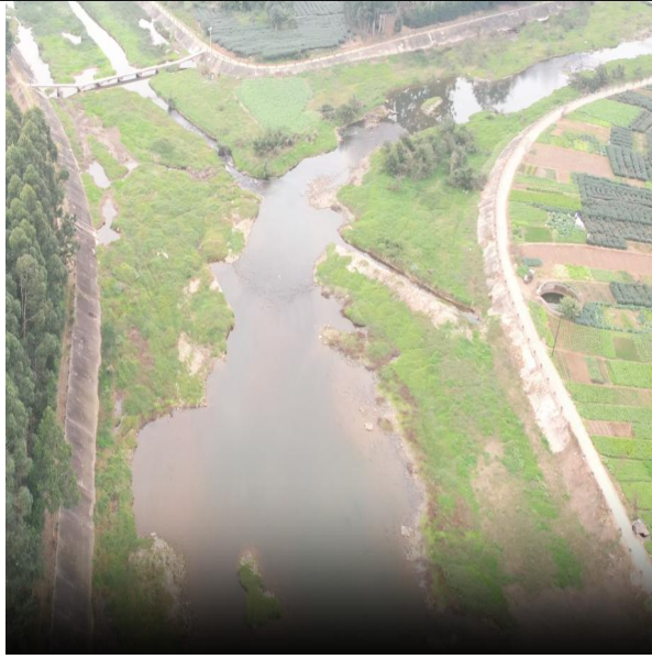
河道淤积现状
