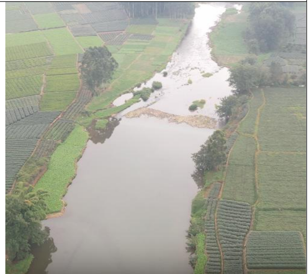
河道淤积现状
