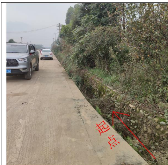
高陶园雨水管网起点
