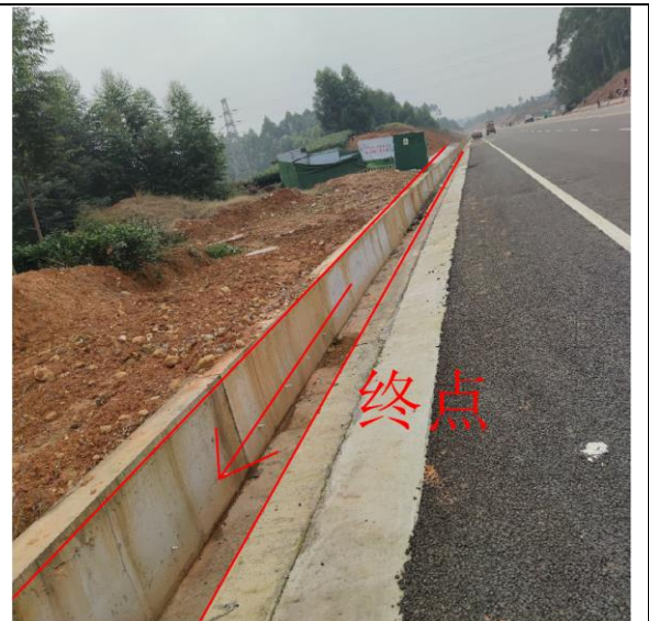
四号线雨水管网终点
