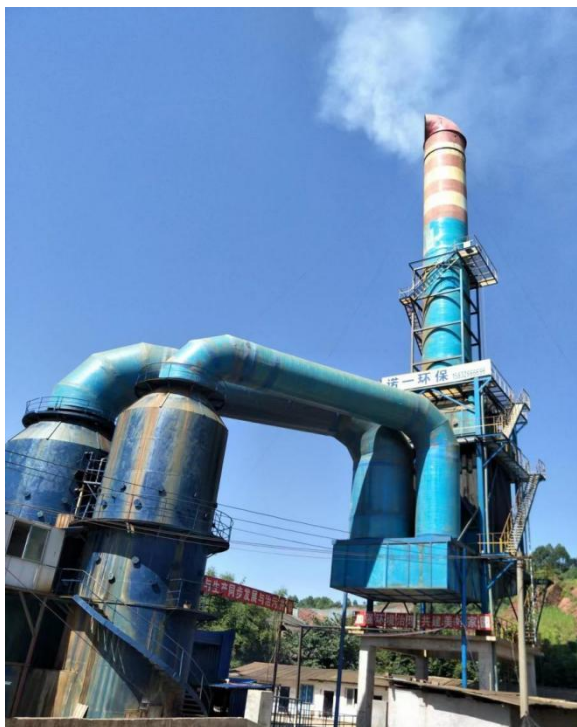
图 2-9 隧道窑烟气脱硫塔图
