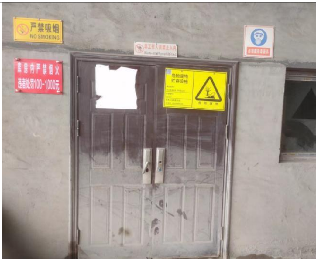
危险废物贮存库
