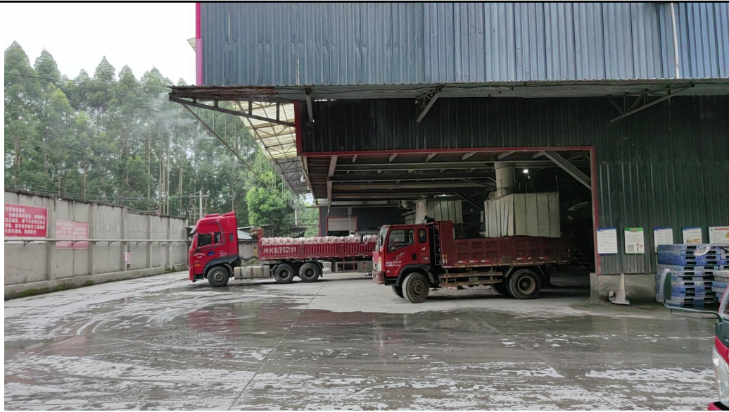
袋装水泥装车处（现有项目情况）
