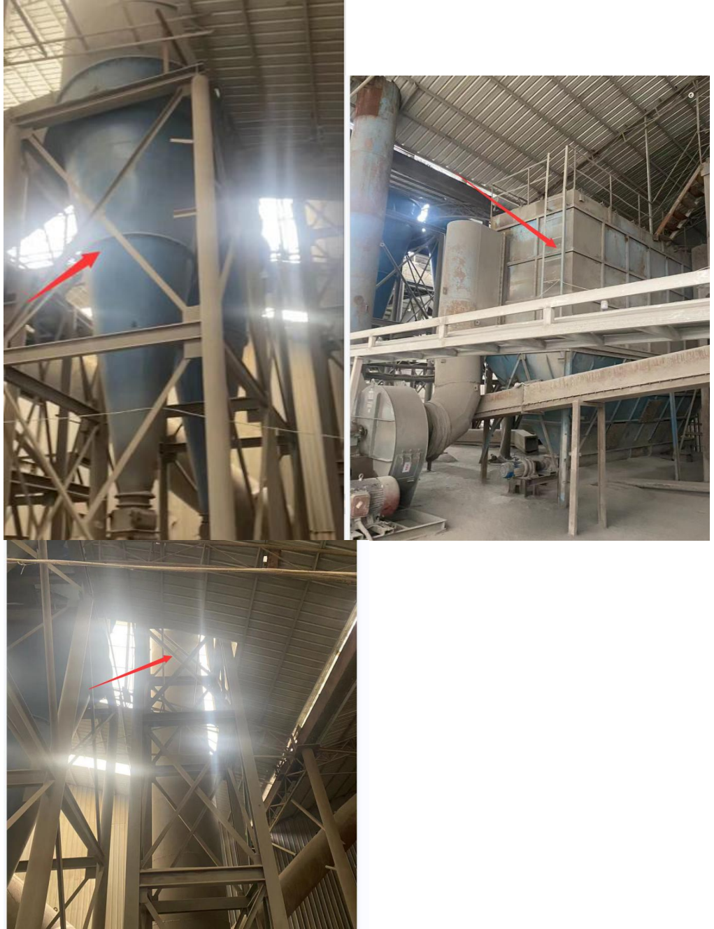
粉磨站旋风+布袋除尘器+32m 高排气筒
